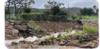
하천 제방 유실
