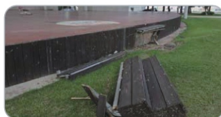
축제장 시설 파손
