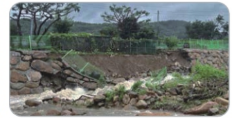
하천 제방 유실
