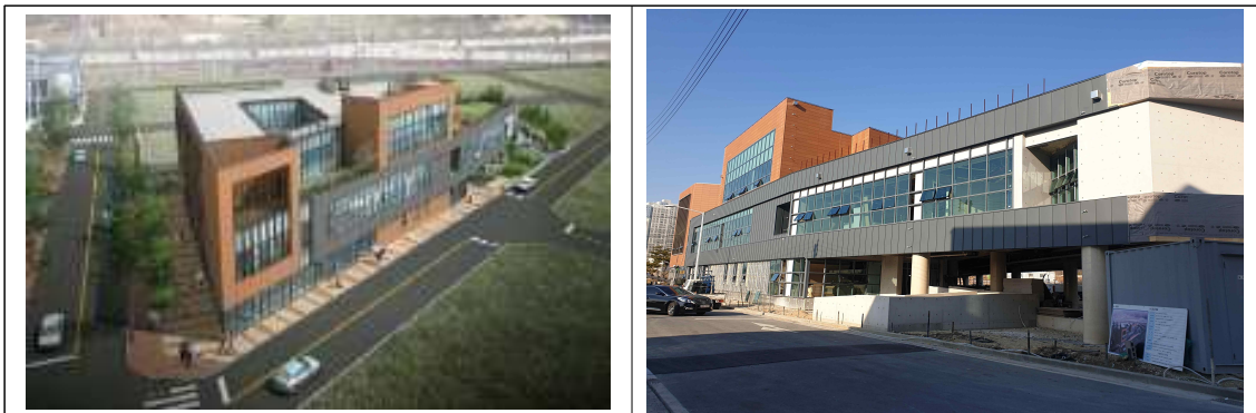
공공산후조리원 조감도 및 공사사진
