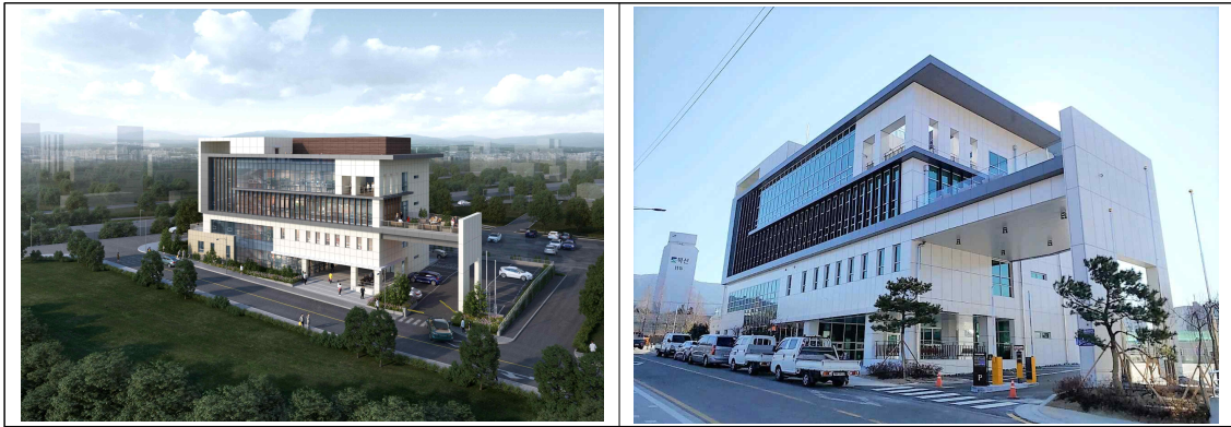
평생학습관 조감도 및 공사사진
